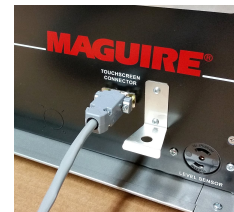
Fernmontagekabel an der Mischer-Steuerung befestigen.
